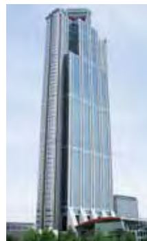
大阪府咲洲庁舎
