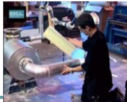
ベンチャークラッドをラミネートした保温材例
