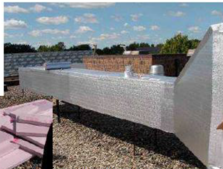
ポリスチレン保温材への施工
